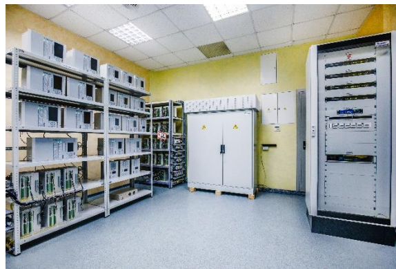
Испытательный полигон «ИНБРЭС» – цифровая модель ПС 500 кВ
